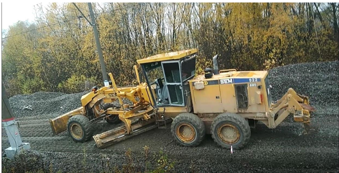
Рисунок 3.9 – Работа автогрейдера
