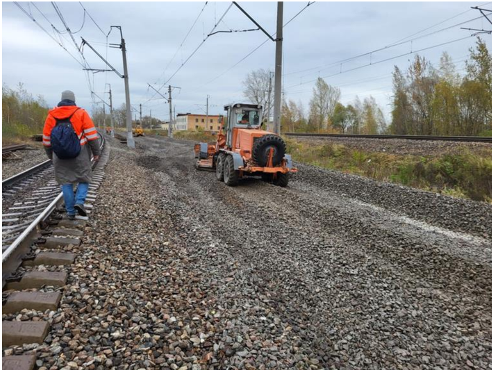
Рисунок 3.3 – Удаление слоя балластной призмы
