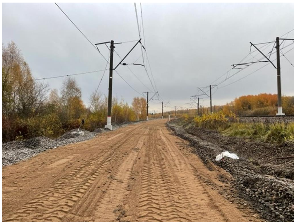
Рисунок 3.5 – Подготовленная основная площадка земляного полотна перед устройством ПЗС
