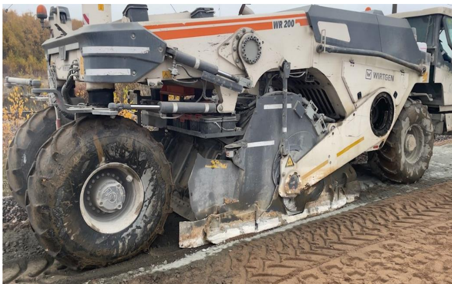
Рисунок 3.7 – Процесс работы ресайклера
