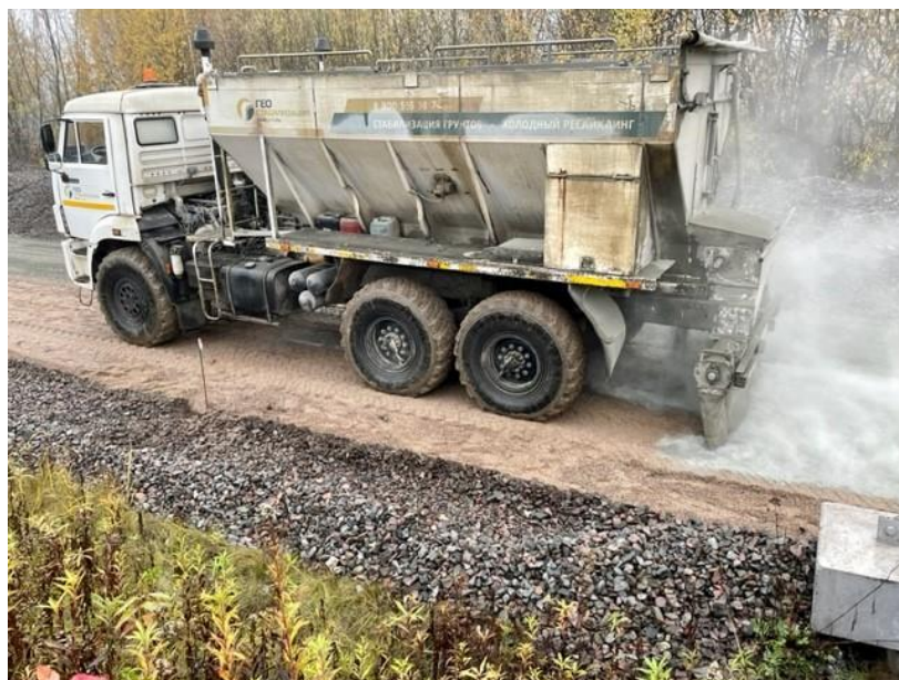
Рисунок 3.6 – Работа распределителя вяжущего
