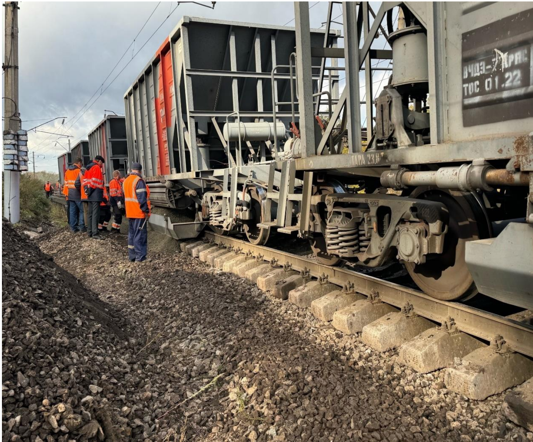
Рисунок 4.4 – Отсыпка смеси ЩПС из хоппер-дозаторных вагонов
