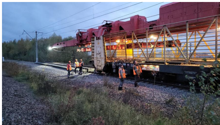
Рисунок 3.2 – Снятие рельсошпальной решетки
