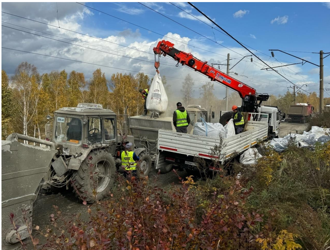
Рисунок 4.5 – Загрузка распределителей вяжущих
