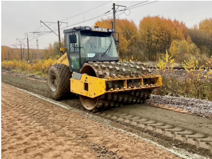
Рисунок 3.8 -Работа вибрационного катка с кулачковым вальцом
